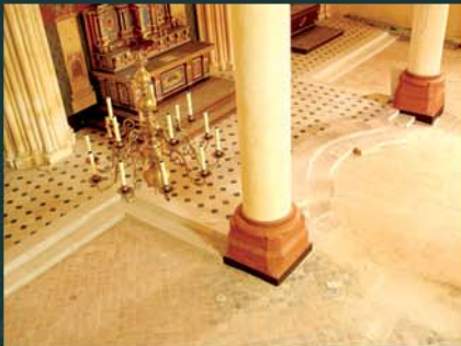
Vue d'ensemble des fondations de l'abside romane et des différents dallages © Lionel Pagès
