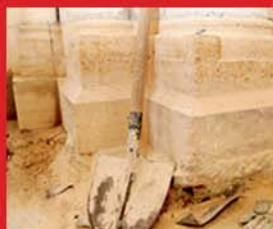
Base de pile en cours de restauration © Lionel Pages
